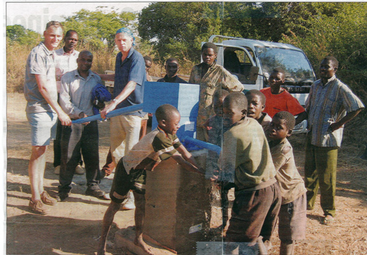
Jos en John Schoorlemmer samen met de plaatselijke bevolking aan het werk bij een van de waterpompen.
