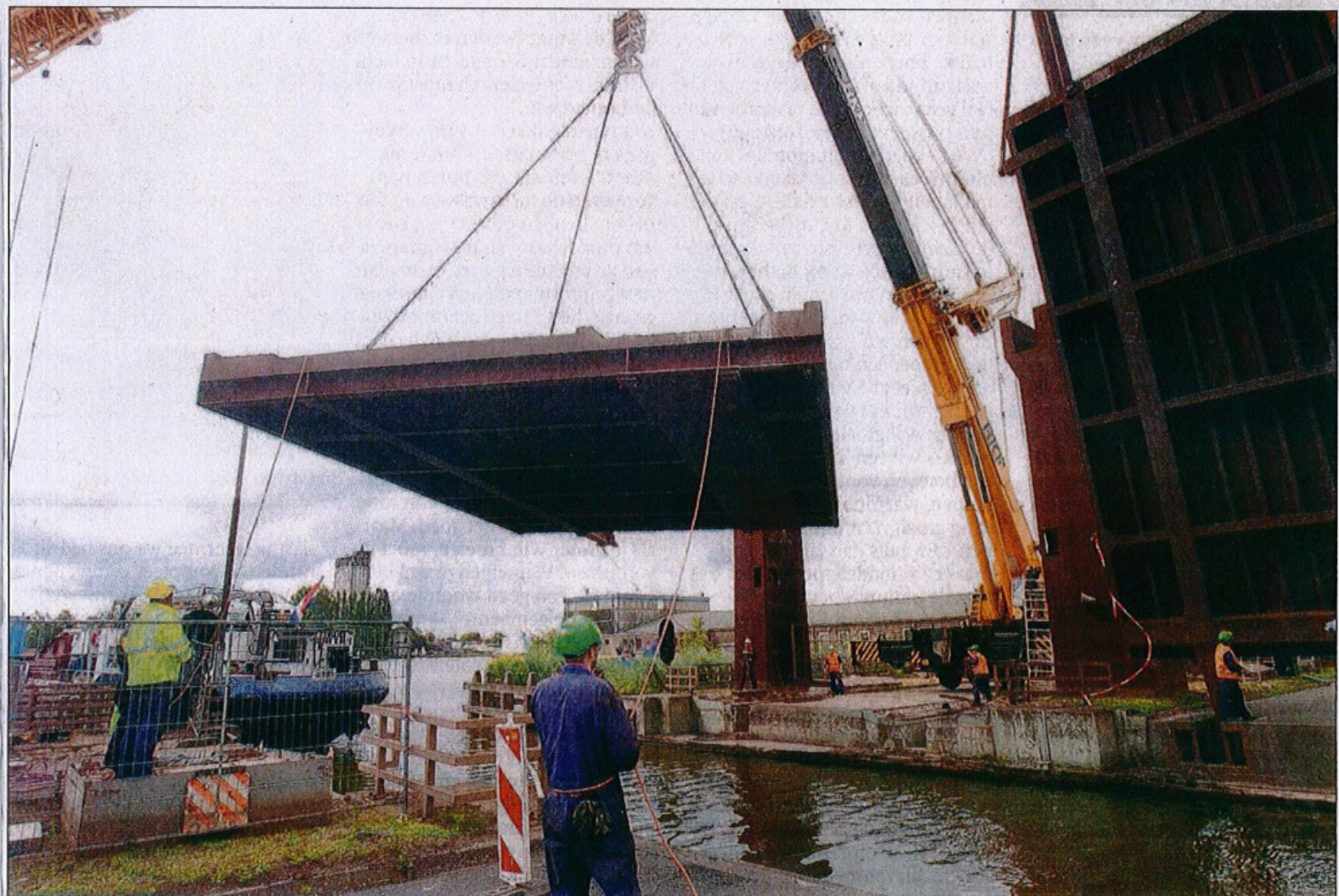
Diep in de middag werd uiteindelijk de loodzware val van Hanzebrug weg getakeld, op een gereedliggend schip gelegd en afgevoerd. foto Ronald Hissink
