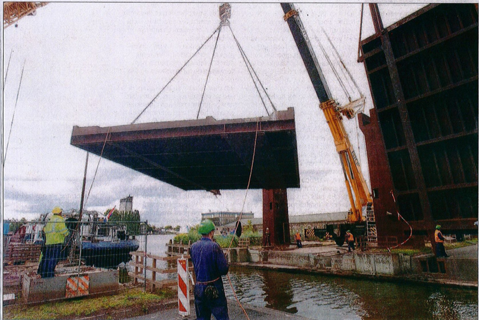
Diep in de middag werd uiteindelijk de loodzware val van Hanzebrug weg getakeld, op een gereedliggend schip gelegd en afgevoerd. foto Ronald Hissink
